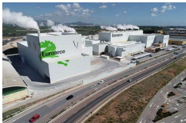
Figura 1. Planta productiva especializada en procesamiento de materias primas y fabricación de pastas atomizadas gestionada por Euroarce en la localidad de Onda
