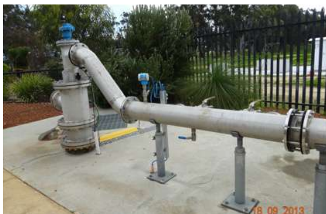
Imagen 3. Sistema de recarga gestionada basada en aguas residuales tratadas en un acuífero en Perth, Australia, después captada por pozos y destinada a abastecimiento público
