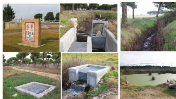
Figuras 3 a a f: Sistema de depuración y recarga empleando NBSs de Alcazarén- Pedrajas. Depuradora de Pedrajas (a); punto de conexión de las aguas regeneradas, fluviales y de escorrentía (b); canal que dirige hacia el punto de conexión las aguas de lluvia de la escorrentía del núcleo urbano de Pedrajas (c); aliviadero contra avenidas esparciendo las aguas en las inmediaciones de un pinar a modo de llanura de inundación (d); válvula del canal 2 (válvula 2) y canal de recarga artificial (e) y arenero empleado como laguna de infiltración (A.W. 2) (f).
